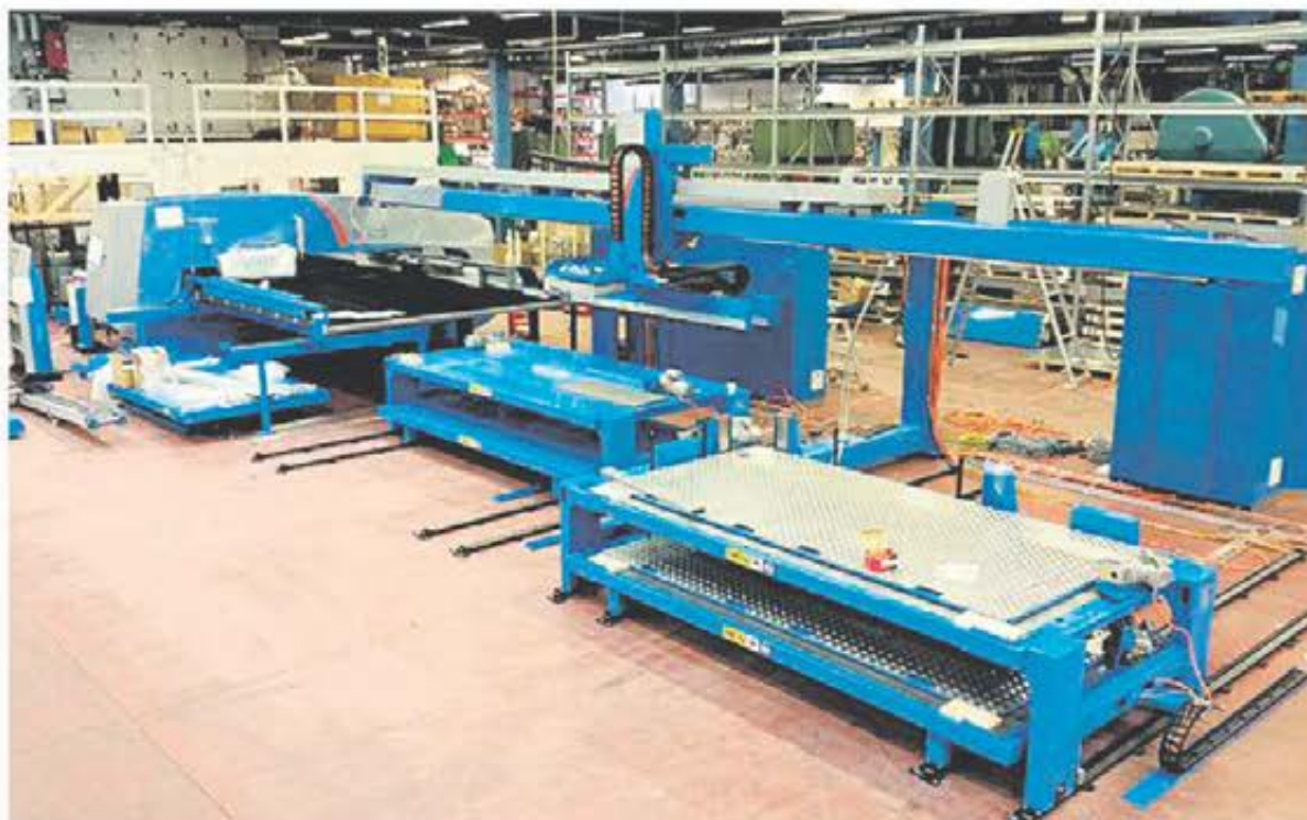
Prima Power E6 LST under installationen på Bors Press
