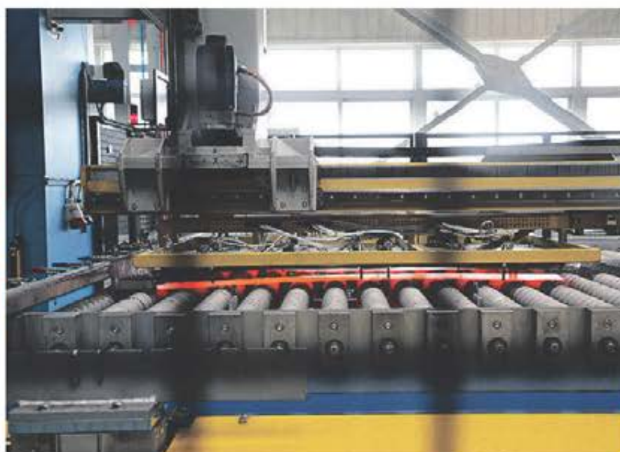
AP&T:s leverans omfattar en nyckelfärdig linje med en ämnesmatare, DST, för matning in i ugnen, en rullugn för upphettning av plåten, två matare av typen SpeedFeeder för matning in och ut ur pressen, en 800-tons ODEN-press inklusive ett verktyg. AP&T har också levererat integration och processkontroll samt utbildning för både operatörer och underhållspersonal.
